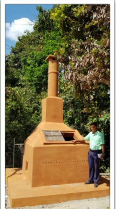
「完成した焼却炉」
